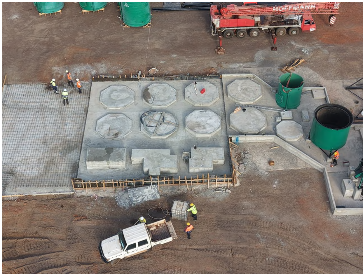
Figure 1 : Avancement des travaux sur les cuves de lixiviation de l'usine pilote modulaire au Sénégal.
