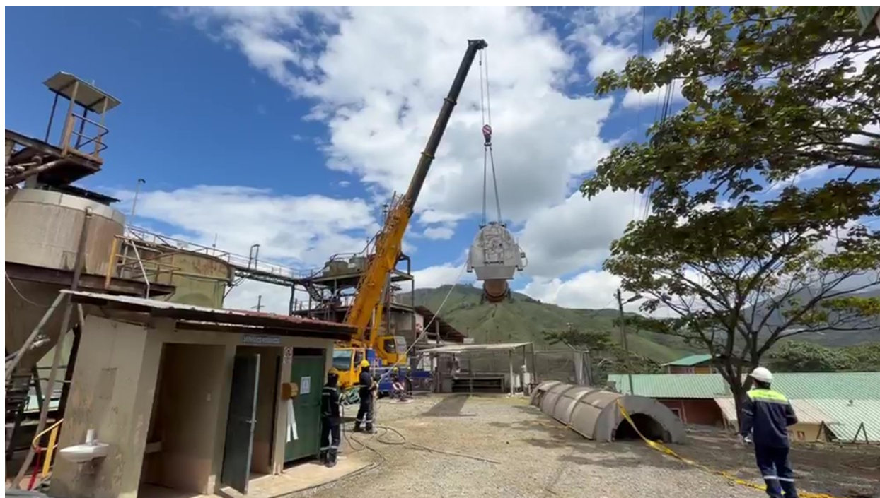
Figure 1 : Remplacement du four de régénération du charbon à Svetlana en Équateur.
