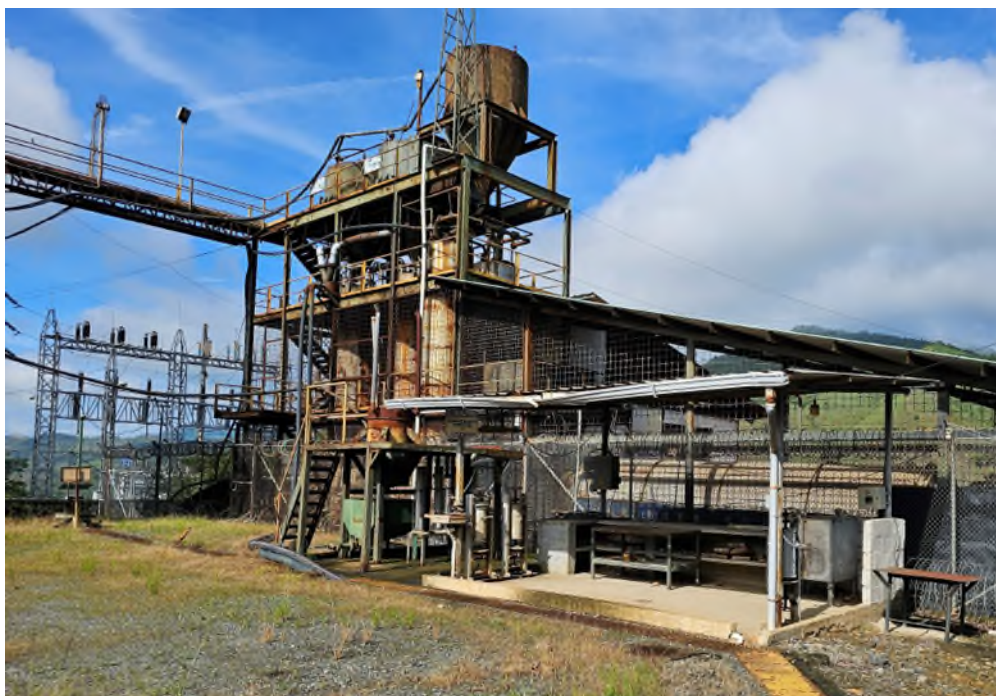
Figure 1 – L'usine de traitement « Svetlana » récemment acquise en Équateur
